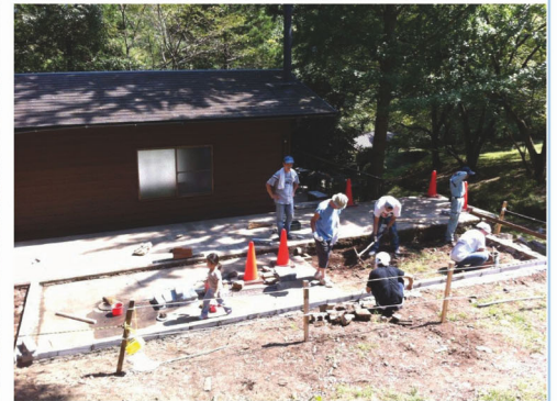
「何とか、基礎工事が完成!?!」
